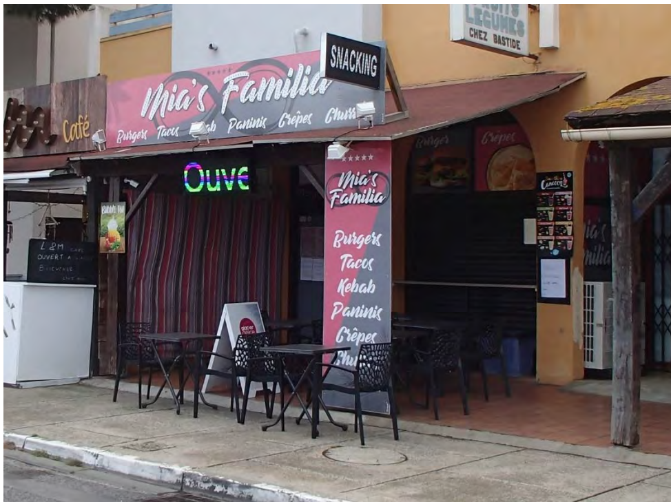
Utilisation d'un pilier qui alourdit l'ensemble de la façade
