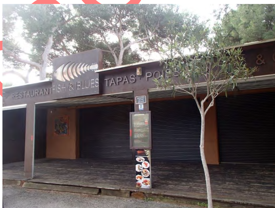
Enseignes dépassant du mur
