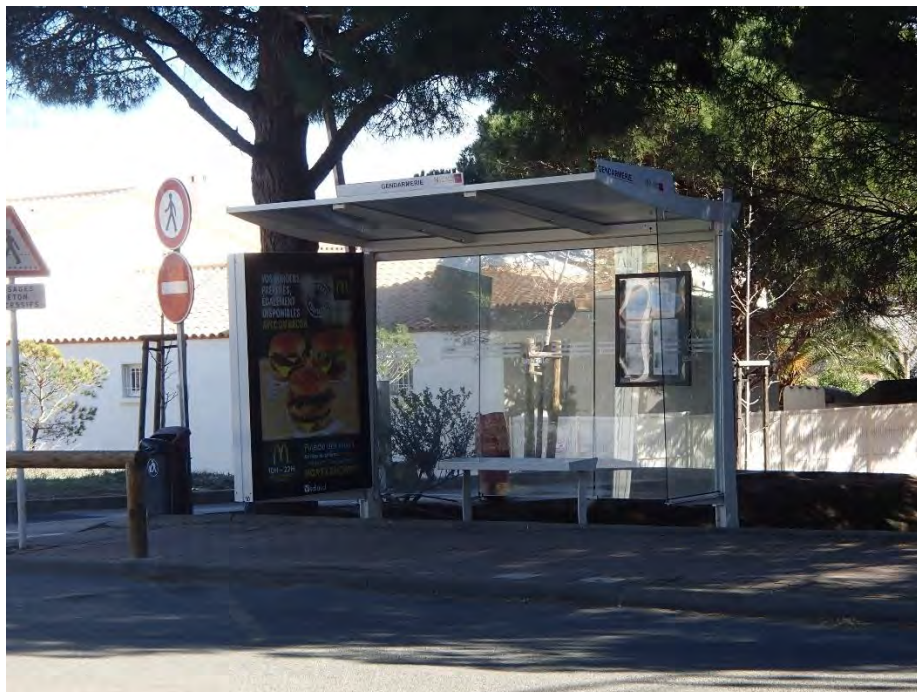
Un abri destiné au public
