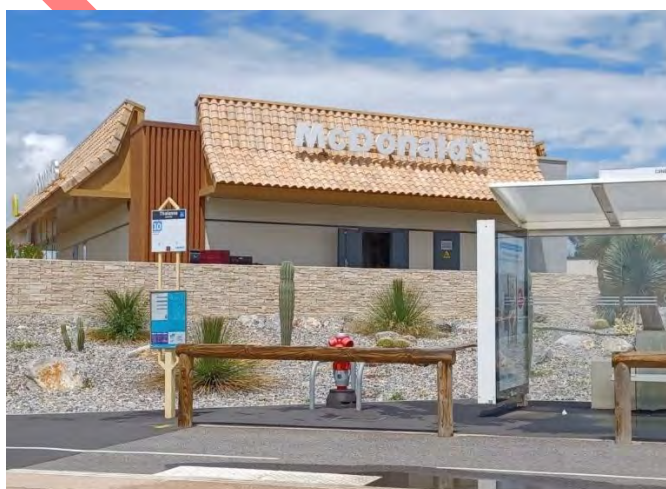
Enseigne sur toiture respectant la réglementation nationale
